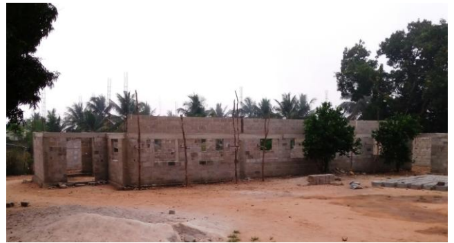
Der Rohbau der Kirche in Mocuba.
